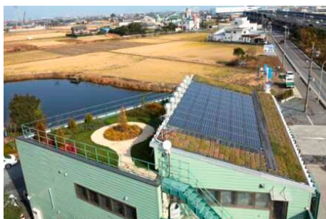
■太陽光発電パネルおよび採光システム■
