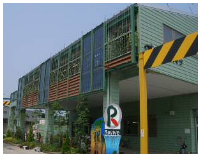
■壁面緑化および太陽光発電パネル■
